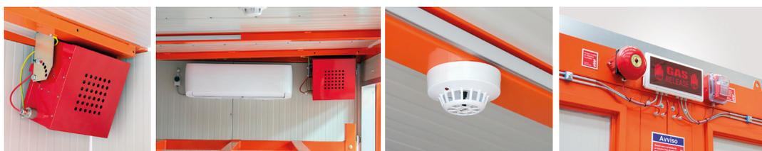
Système de suppression d'incendie à aérosol concentré - certifié KIWA Détection rapide d'incendie avec détecteurs de fumée et thermiques
